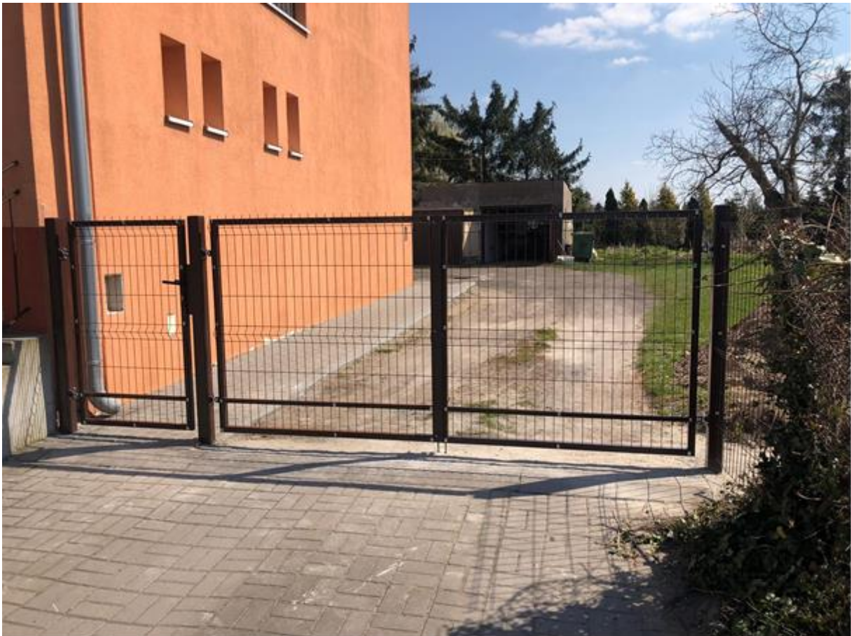
Brama wjazdowa WOK Wałdowo
